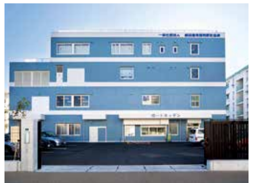
山下厚生センター別館
